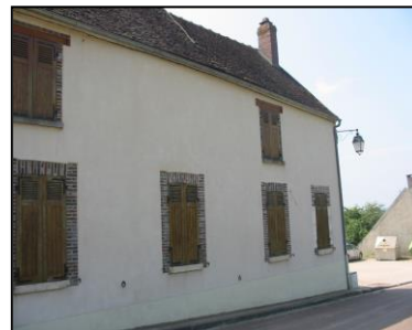
Encadrement des ouvertures
