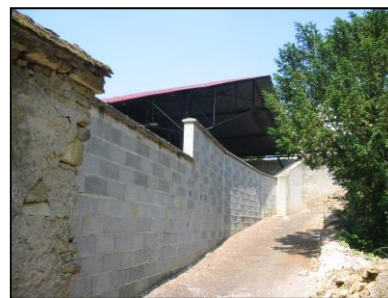
Ferme dans le centre
