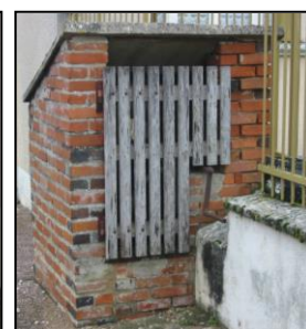
Puits, chemin rural de la fontaine
