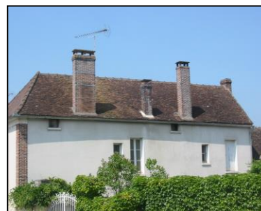
Toiture en petite tuile de Bourgogne
